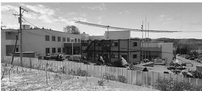
改修工事中の町民センター
